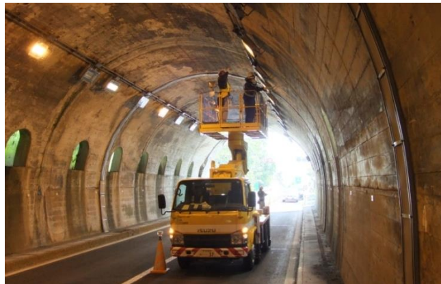
写真一解 3. 1 近接目視作業状況
