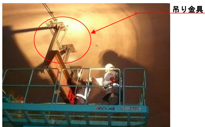
写真－解 3. 3 触診作業状況
