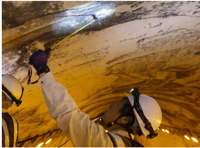
(a) トンネル本体工
