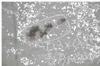
写真 変色の例（テキスト（トンネル編）85 頁）
