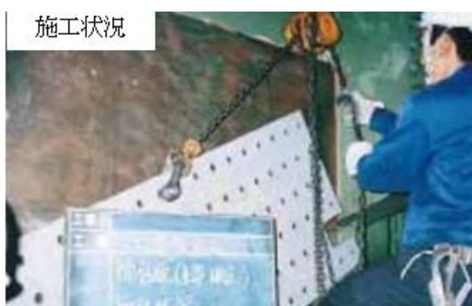
写真 3 当て板（鋼板）による補修の施工例（切欠き部）
