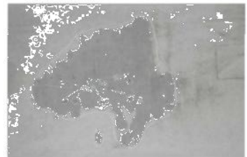
写真 変色の例（テキスト（トンネル編）85 頁）
