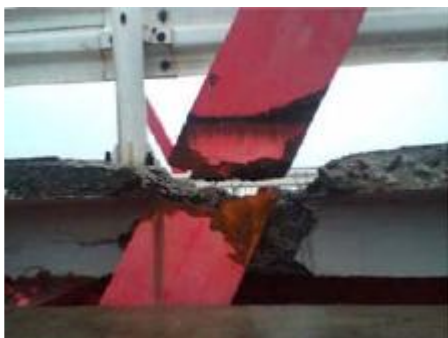
写真 トラス橋の弦材破断の応急対策
